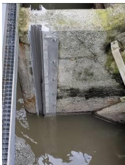
Montage der Profile für die Dammbalken
