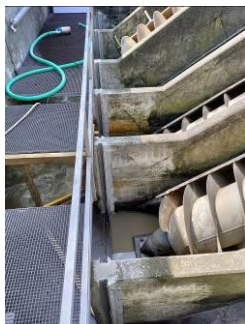
Montage der Profile für die Dammbalken
