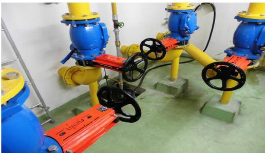
Beim Pumpwerk Schornen mussten wir altershalber (20 Jahre) vier Schieber und Rückschlagklappen ersetzen. Das war der erste Schritt zur Sanierung des ganzen Pumpwerks, die wir im Budget 2017 realisieren möchten.
